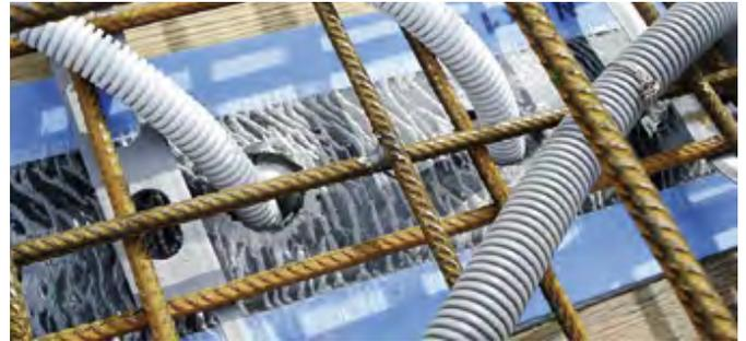
Une fois la maçonnerie terminée, les conduites peuvent être tirées dans les canaux de câblage prévus à cet effet.
