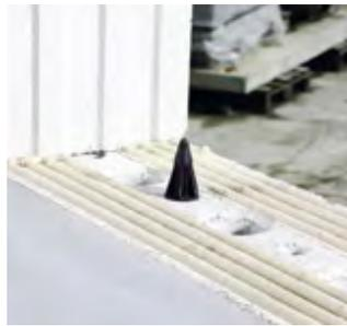
Le mortier est posé en couche mince avec le charriot à mortier. L'épaisseur de la couche compte environ 2 mm.
