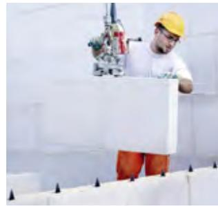
Une personne pose, à l'aide de la mini-grue, jusqu'à 0.5 m<sup>2</sup> de mur par opération. Les joints verticaux sont posés à sec, sans mortier. Les goujons de centrage garantissent l'alignement des canaux de câblage.
