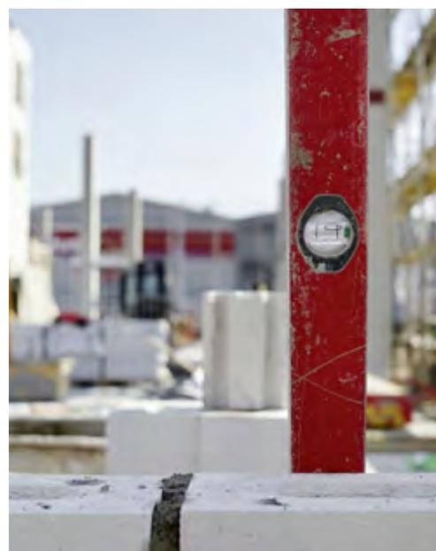
► Maçonnerie précise et plane avec la brique silico-calcaire
