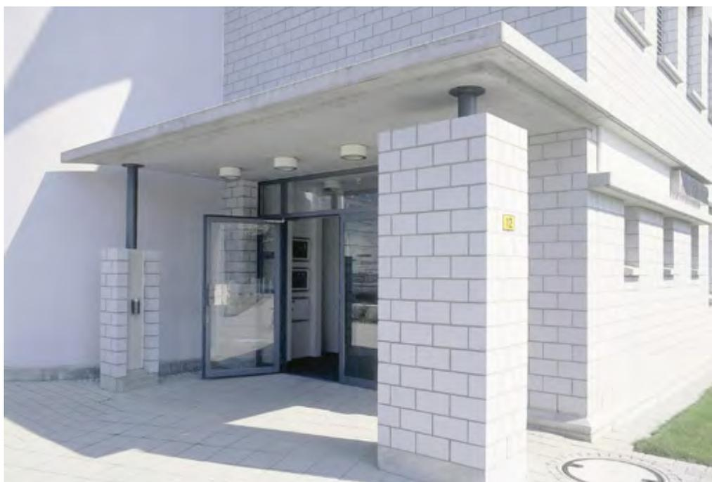
▲ La maçonnerie en briques silico-calcaires offre de multiples possibilités d'exécution
