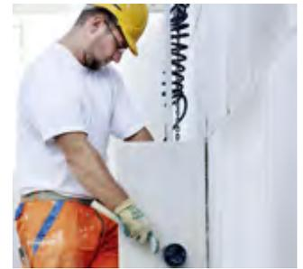
Les jonctions de maçonneries sont en général réalisées aboutées, au mortier. A chaque couche, des ancrages doivent être posés.
