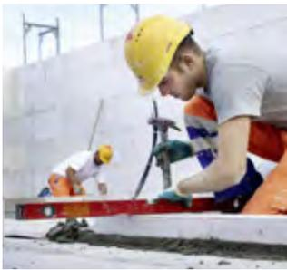
La maçonnerie des briques commence par la pose, à niveau, des briques de compensation.
